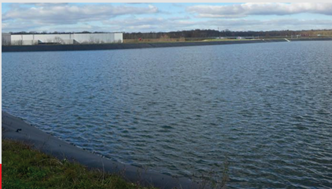
Le bassin d'irrigation de la Boulouze à Fauverney est un exemple abouti de bassin d'irrigation avec récupération des eaux pluviales de la zone d'activités voisine.
