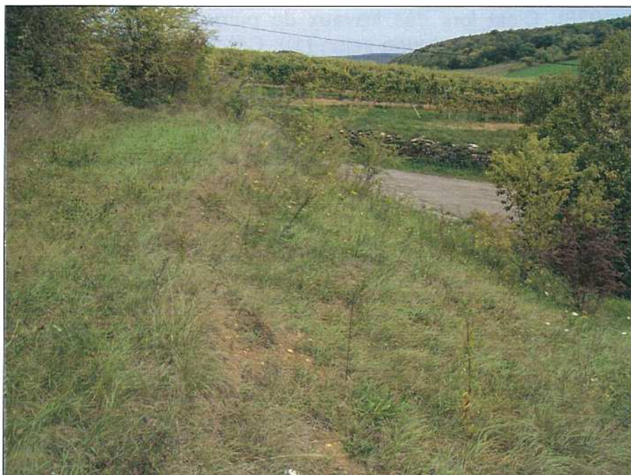
Figure 13: Petit glissement actif dans le talus amont de la voie d'accès au centre de loisirs d'ÉVELLE.
