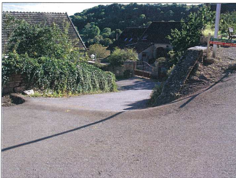
Figure 10: Aménagement destiné à limiter les effets du ruissellement (bourrelet d'enrobé à ORCHES).
