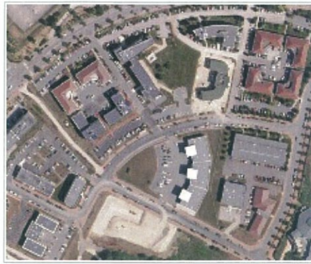
Zone d'activités tertiaires : quartier Maladières-Varenes-Coteaux de Suzon (Google Earth 2012)
