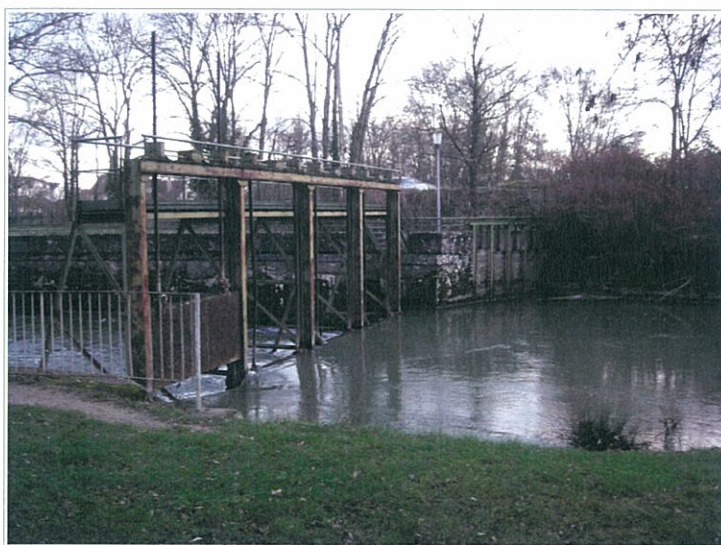
Prise d'eau sur l'Ouche permettant d'alimenter le canal de Bourgogne.
