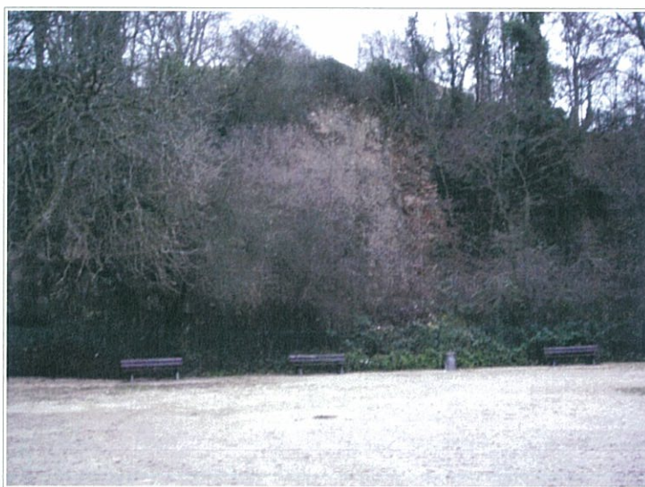
Carrière du parc Bacquin, l'affleurement situé derrière les bancs est conforté par des tirants (clous) sellés dans le massif rocheux (points clairs en tête d'affleurement).
