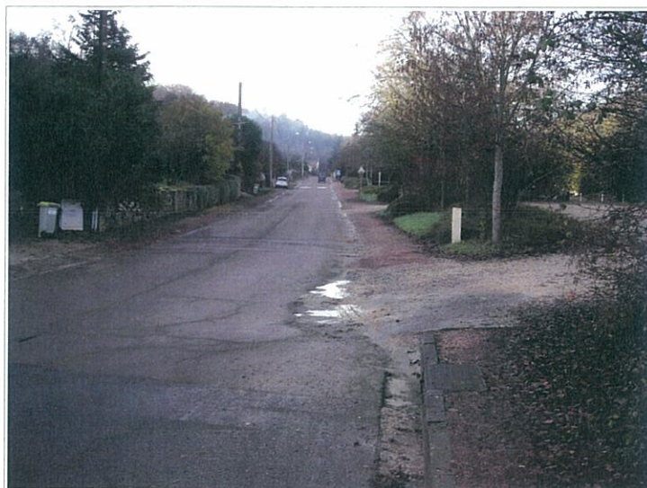
Débouché de la combe à la Serpent, on notera le point bas formé par la chaussée (zone d'accumulation d'eau).
