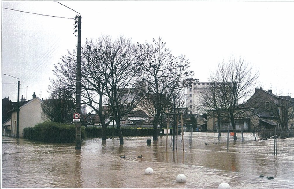
Crue de l'Ouche de mars 2001, la rivière a débordé sur la rue de l'Île, inondant un quartier résidentiel proche du cours d'eau.
