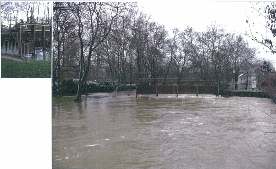
Crue de l'Ouche du 24 décembre 2010, la rivière a débordé aux abords du camping (crue de faible importance a priori). Cette photo montre le niveau atteint par l'eau au niveau de la prise d'eau alimentant le canal de Bourgogne (prise d'eau proche de l'écluse). Les vannes de la rivière sont levées (centre de la photo) et celles du bief d'alimentation du canal sont maintenues baissées bordure droite de la photo). On notera qu'une élévation de quelques décimètres du niveau d'eau peut mettre en péril la prise d'eau avec pour conséquence une activation du bief. En médaillon en haut à gauche le même endroit en temps normal.
