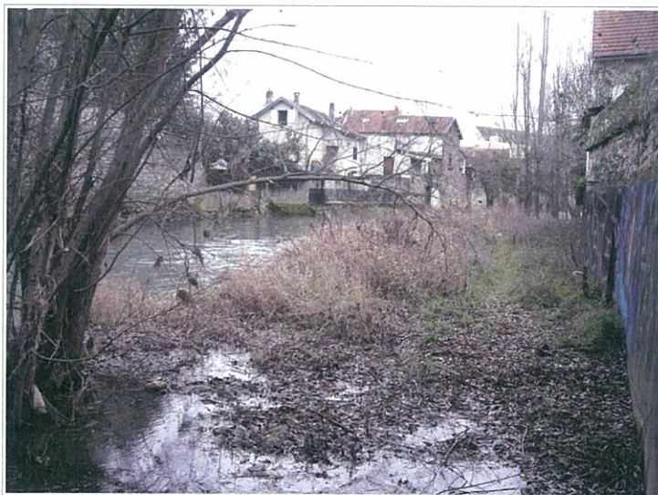
Vue du lit de l'Ouche à l'amont de la voie ferrée. Des débordements importants sont signalés par l'étude hydraulique dans ce quartier. On notera l'encombrement du lit, ce qui peut nuire aux écoulements.
