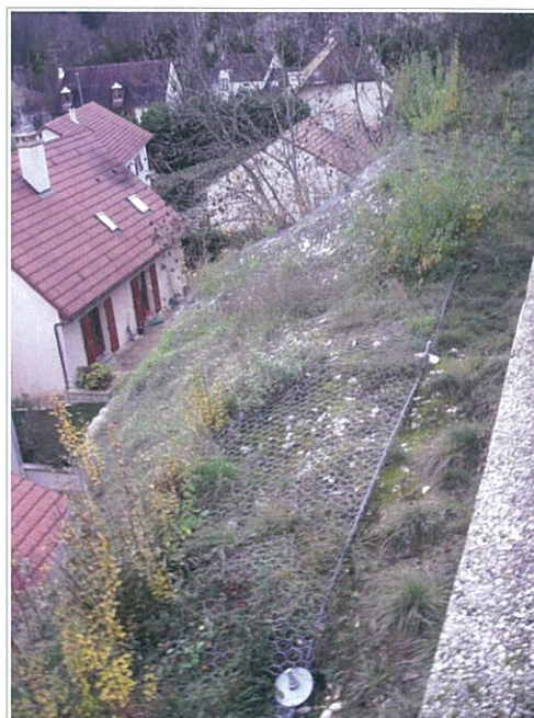
Photo de gauche : gros plan sur le massif rocheux, on notera sa fissuration. Photo de droite : vue de l'ancrage du filet, on notera sa maille très fine ainsi que la proximité du mur avec le bord de la falaise (bordure droite de la photo).
