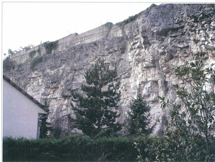
Vue générale du front de taille de la carrière. On notera la proximité de la maison et la présence du mur en tête d'affleurement. Ce secteur est pourvu un filet dont on distingue la maille en haut à droite de la photo (zone grisée).
