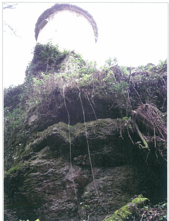
Cordon rocheux érodé au droit du centre de loisirs de la Bergerie et vue la tour construite à l'aplomb de l'affleurement.
