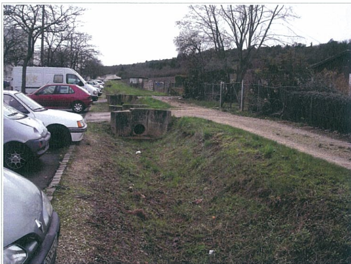
Fossé aménagé en pied de versant parallèlement à la rue Dunant pouvant collecter les ruissellements du coteau amont.
