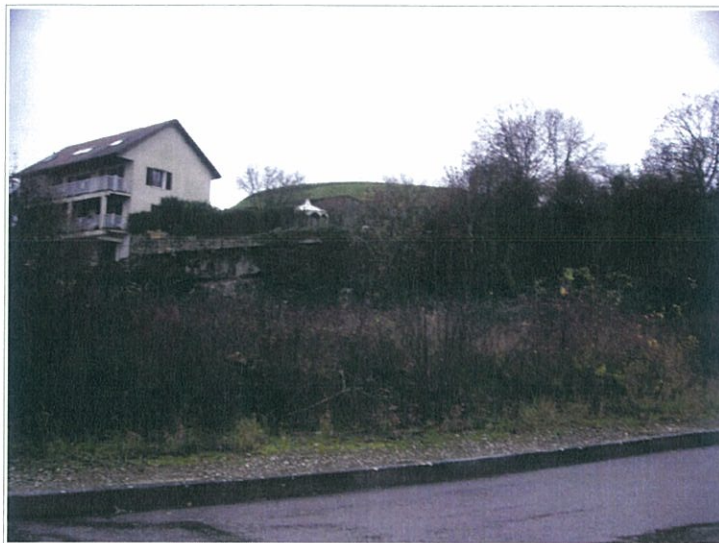
Vue générale de la carrière de la rue Jules Verne. On distingue le front de taille derrière la friche et les arbres.
