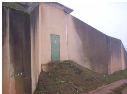
Vue Extérieure du Réservoir
