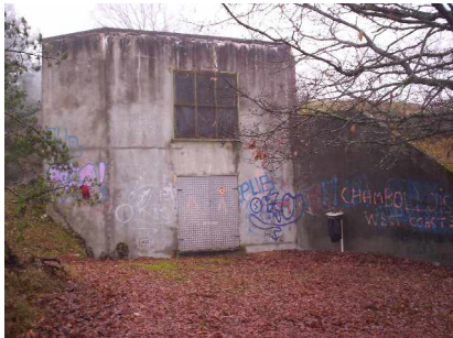
Vue extérieure du réservoir
