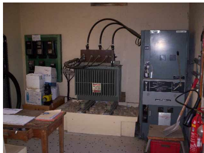
Cpt EDF, Tranfo et Cellule HT
