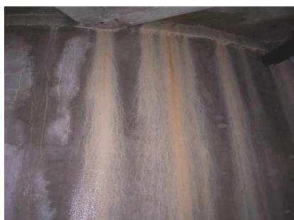
Traces d'Infiltration
